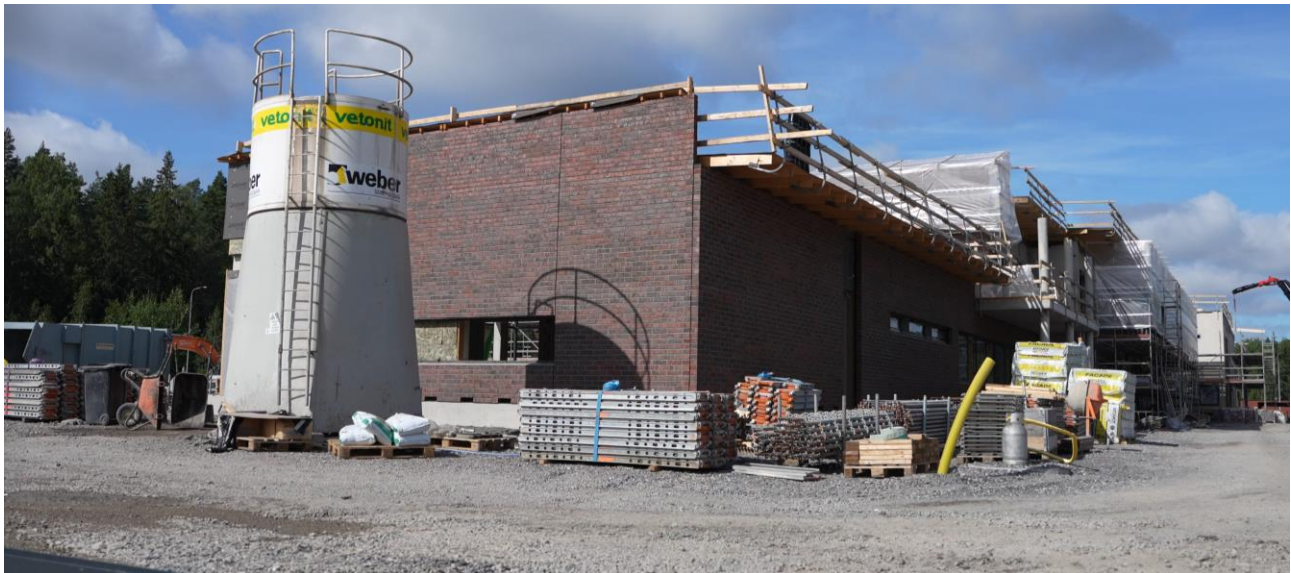
Kuva 25. Krossin pelastus- ja ensihoitoasema rakentumassa kesällä 2024. Kuvaaja: Kristian Eloluoto.
