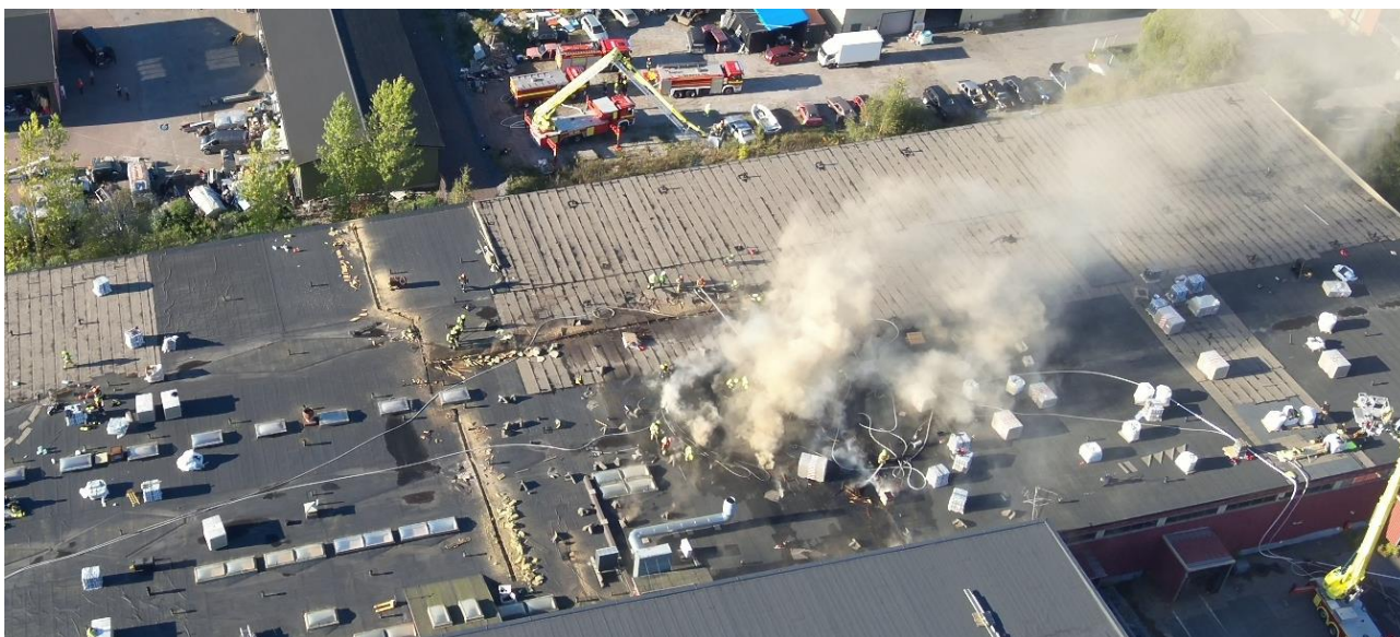
Kuva 20. Teollisuusrakennuksen tulipalo Raisiossa.
