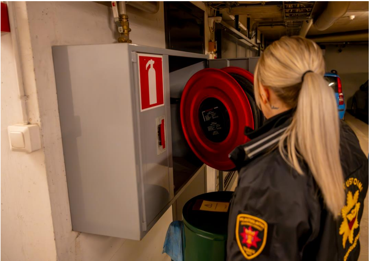
Kuva 13. Palotarkastaja Sonja Pohjosaho suorittamassa kerrostaloyhtiön palotarkastusta. Kuvaaja: Kristian Eloluoto.
