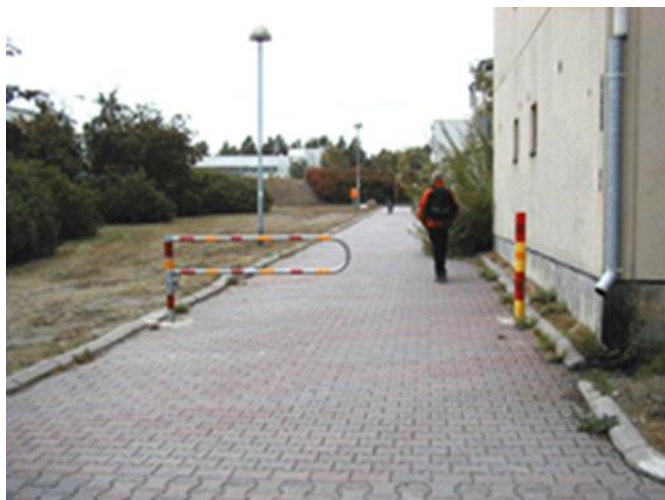
Bild 9. Exempel på placering av en bom på en räddningsväg.
