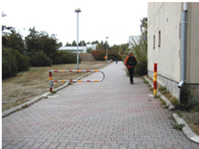
Kuva 9. Esimerkki puomin sijoittamisesta pelastustielle.
