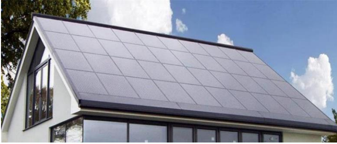
Katteeseen integroidut aurinkopaneelit (Kuva: Solarguide)
