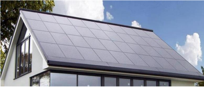
Katteeseen integroidut aurinkopaneelit (Kuva: Solarguide)
