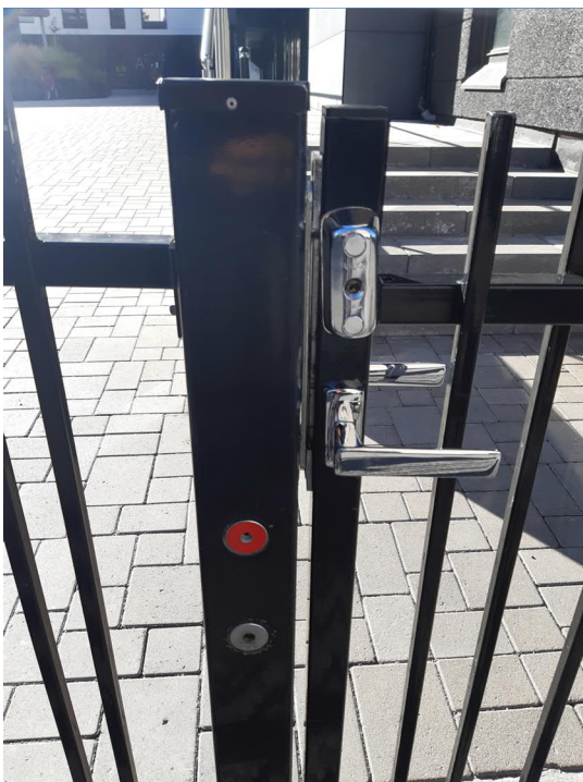
Kuva 3 Esimerkkikuva portin ulkoavainsäilöstä (kuvassa vielä vanhanmallinen avainsäiliö)
