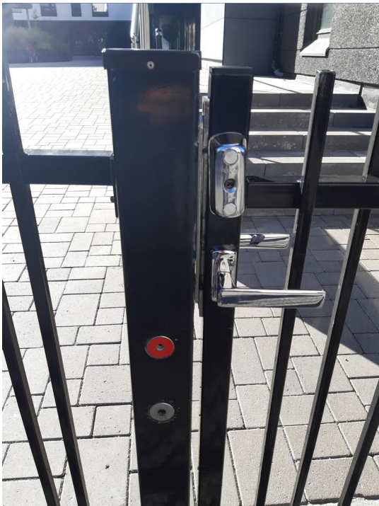
Kuva 3 Esimerkkikuva portin ulkoavainsäilöstä (kuvassa vielä vanhanmallinen avainsäiliö)
