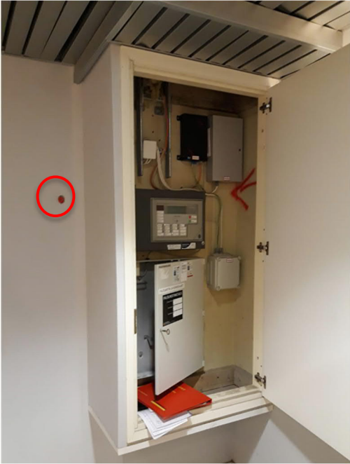
Kuva 2 Esimerkkikuva sisäavainsäilön sijoittamisesta (kuvassa vielä vanhanmallinen avainsäiliö)
