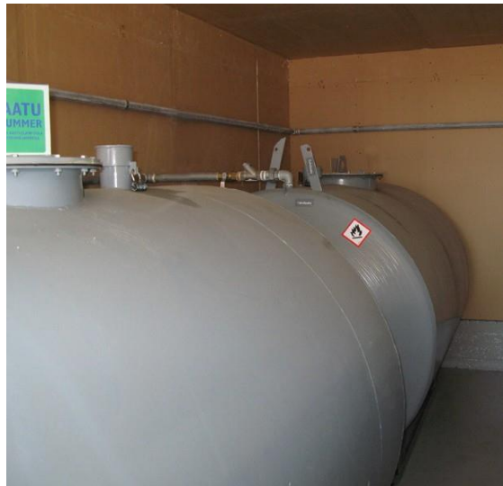
Foto: Birkalands räddningsverk
