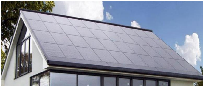
Katteeseen integroidut aurinkopaneelit (Kuva: Solarguide)
