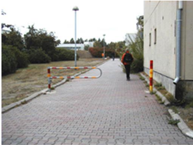
Kuva 9. Esimerkki puomin sijoittamisesta pelastustielle.
