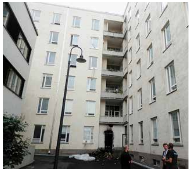
Naistenklinikan jätehuoneen tulipalo, jossa savukaasut levisivät useampaan kerrokseen avoimena olevien parvekeovien takia.
