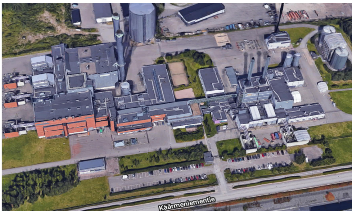
Kuva 1. Vuosaaren voimalaitoksen A- ja B-voimalaitokset. (Lähde: Google Maps)
