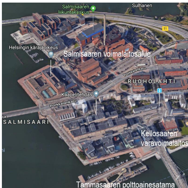
Kuva 1. Salmisaaren voimalaitosalue, Kellosaaren varavoimalaitos ja Tammasaaren polttoainesatama muodostavat tiiviillä kaupunkialueella sijaitsevan toiminnallisen kokonaisuuden (Lähde: Google Maps).
