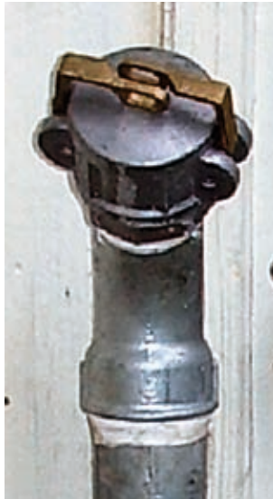
Säiliön täyttöputki
